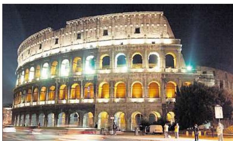
Steht möglicherweise gefährlich nahe an der neuen U-Bahn-Baustelle: das berühmte Kolosseum von Rom.
